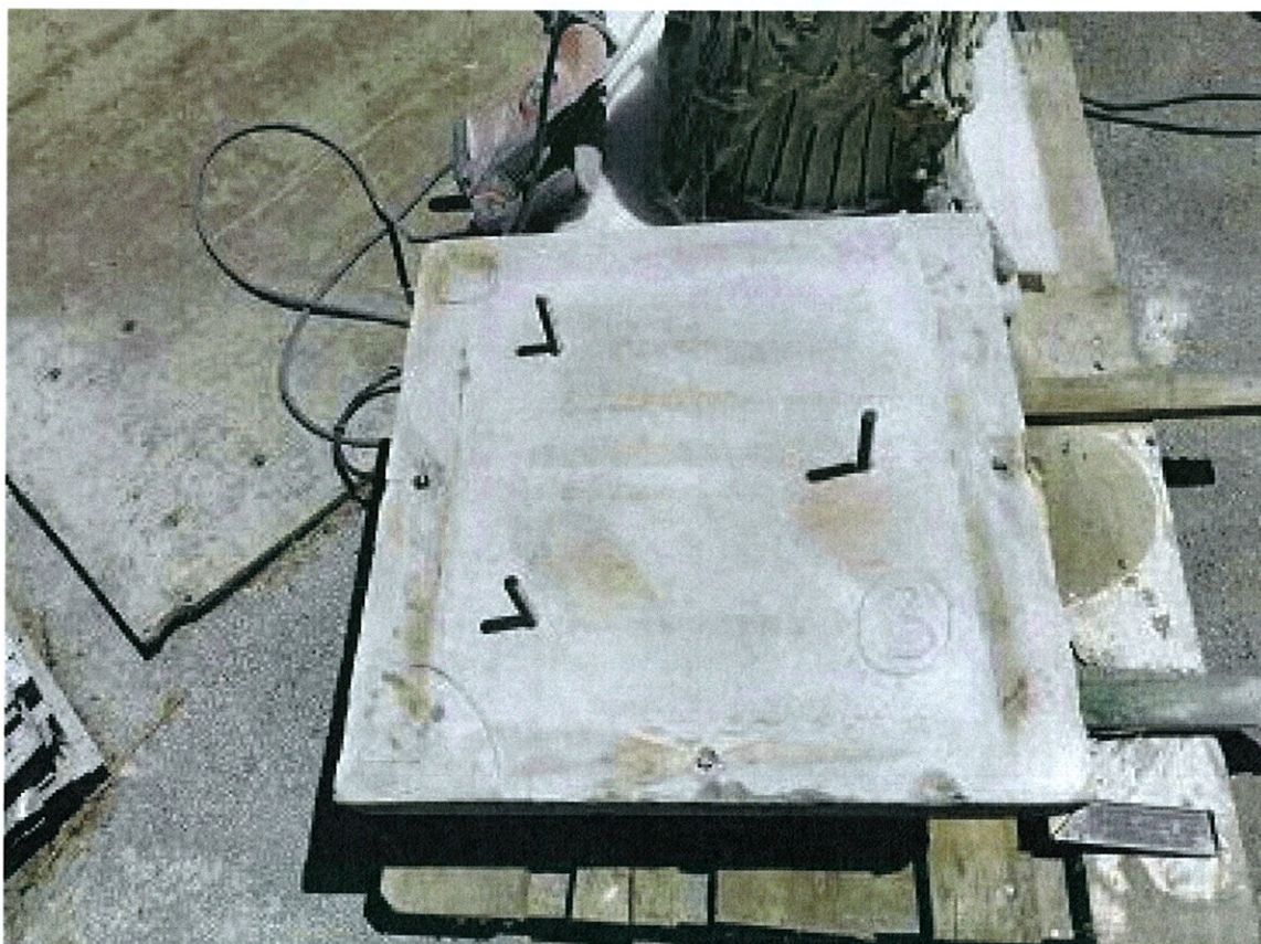
A faragványok előkészítése helyezéshez
